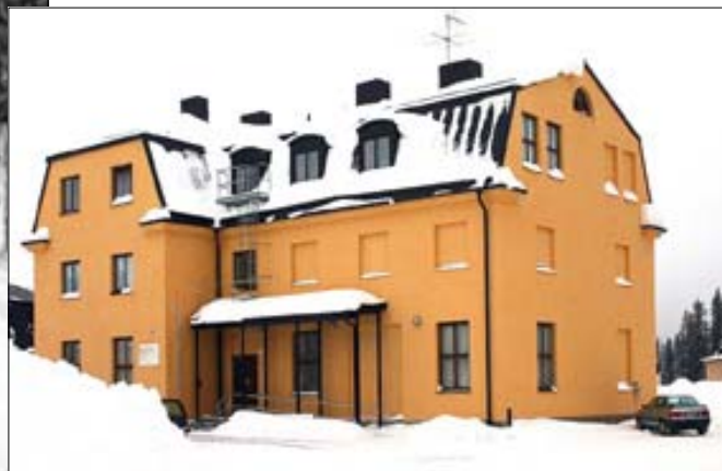
Så ser den ut idag, byggnad 4, Kårens gamla verkstads- och lektionssalsbyggnad. Sedan 2003 finns här Försvarsmaktens Regionarkiv i Norrbotten.
