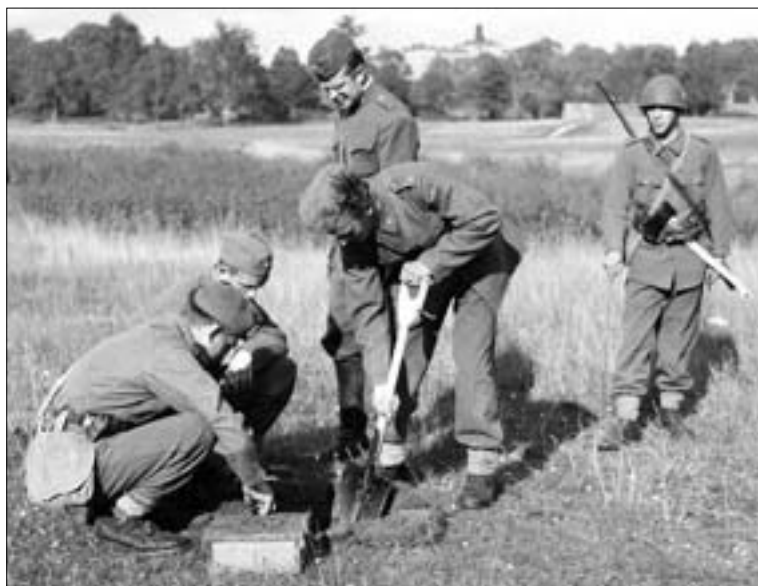
Utläggning av stridsvagnsmina m/43. Ingenjörssoldaterna är iförda uniform m/39, fältmössa m/39 och damasker m/39.
