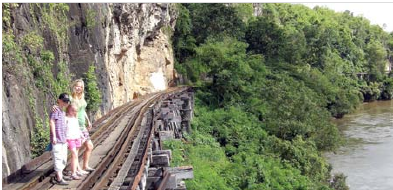
Wang Phoviadukten, i allt väsentligt utdriven för hand, är en L-formad utskärning i det mot floden Kwai brant sluttande berget...
