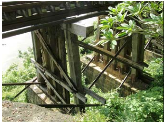
...spåret vilar på en träkonstruktion, med förstärkningar i sidled i viaduktens kurviga delar.
